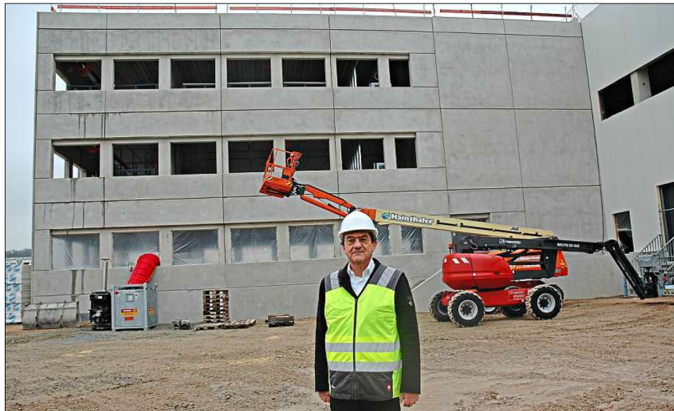
Halbzeit auf der Baustelle: Der Neubau soll 2026 bezugsfertig sein. Geschäftsführender Gesellschafter Florian Leebmann und seine Mitarbeiter haben lange auf die Umsetzung der Pläne gewartet.
